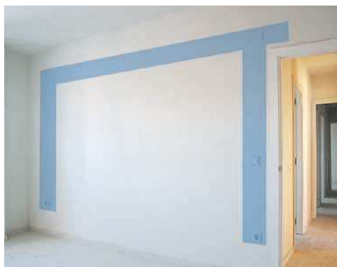
24. Bandas por donde discurren las instalaciones. Salón.
