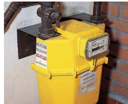
21. CONTADOR INDIVIDUAL Y LLAVE DE CORTE.
