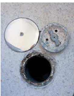
10. BOTE SIFÓNICO CON TAPA DESMONTADA.
