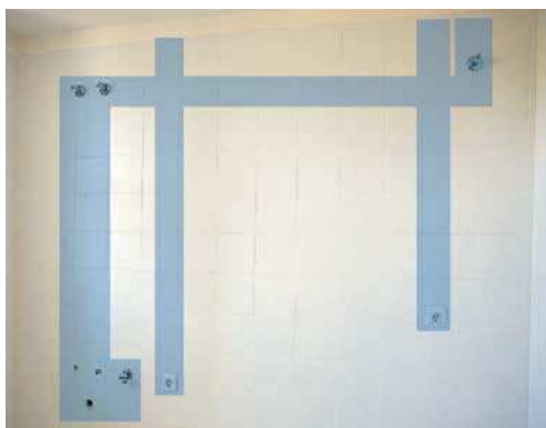
23. Bandas por donde discurren las instalaciones. Cocina.
